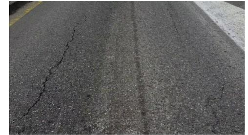
**D4.** Fisura longitudinal aislada presente en trayectorias de rueda/no rueda.
