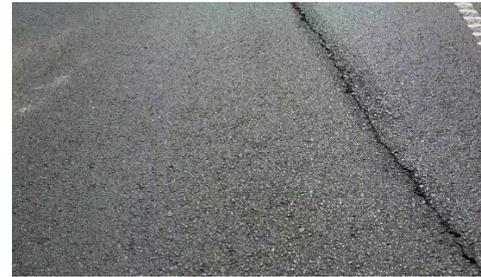
**D3.** Fisura aislada que atraviesa la carretera en dirección diagonal.
