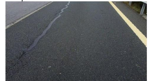
**D13.** Fisura reparada con sellador adhesivo.
