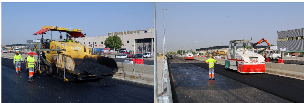
Figura 13. Extendido y compactación
