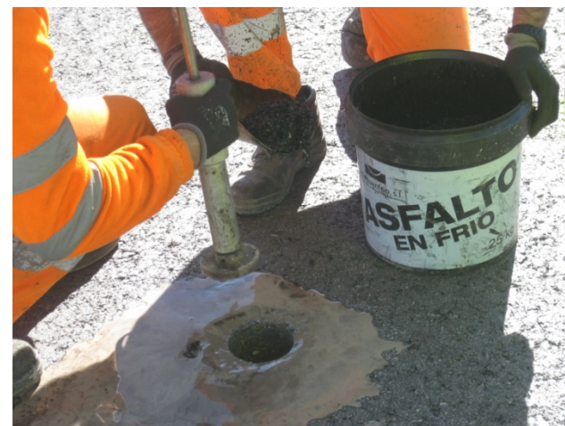
Relleno y compactación
