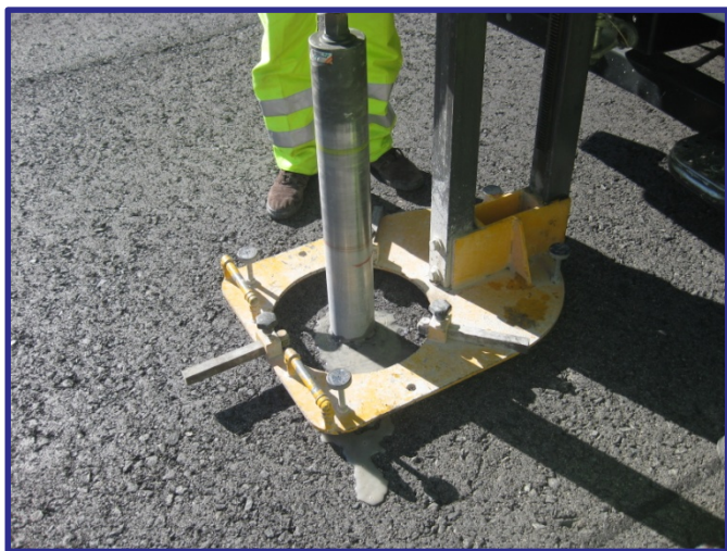
Hincado para extracción
