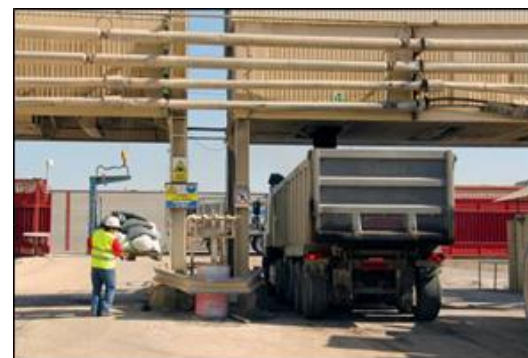
Fabricación mezcla bituminosa
