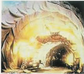
Fig. 4. Dren rodeando a un túnel
