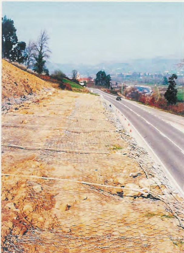
FIGURA 12. Zona de coronación. Vista de la zona excavada, para la colocación retirada de los anclajes de coronación.
