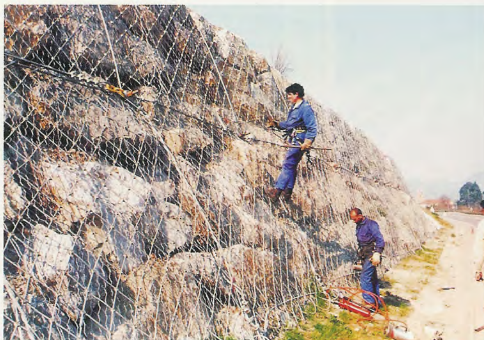
FIGURA 16. Tensado de anclajes III.
