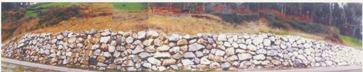
FIGURA 6. Vista general del muro.
