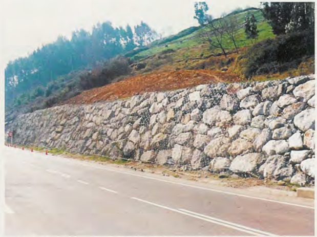
FIGURA 18. Vista general de la solución de refuerzo terminada.
