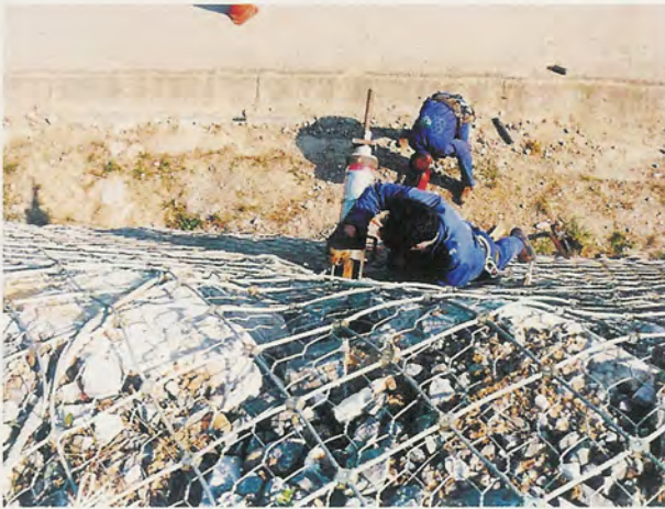
FIGURA 17. Tensado de anclajes IV.
