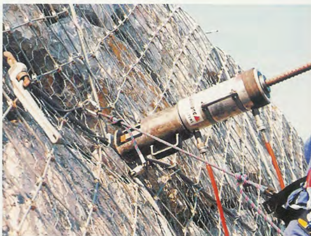
FIGURA 14. Tensado de anclajes I. Colocación del gato en la fila central de barras GEWI.
